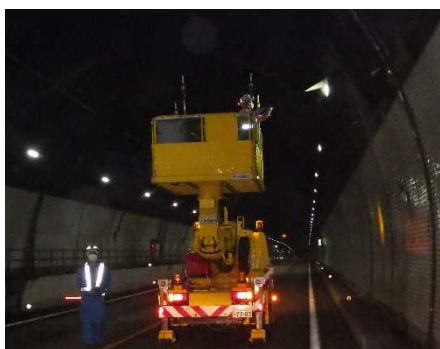
トンネル照明点検状況
