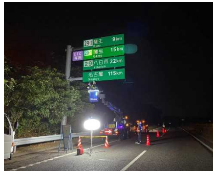
標識点検状況
